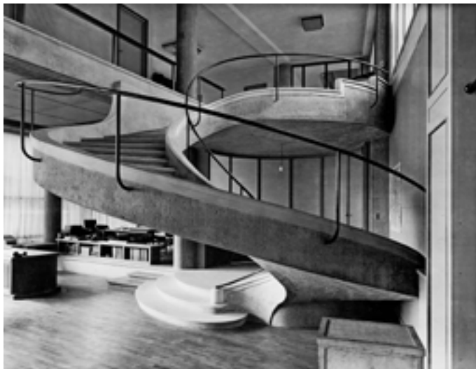
Auguste et Gustave Perret immeuble d'habitation et agence 51-55, rue Raynouard, Paris 16 e , 1929-1932, vue de l'escalier de l'agence, photo non datée
