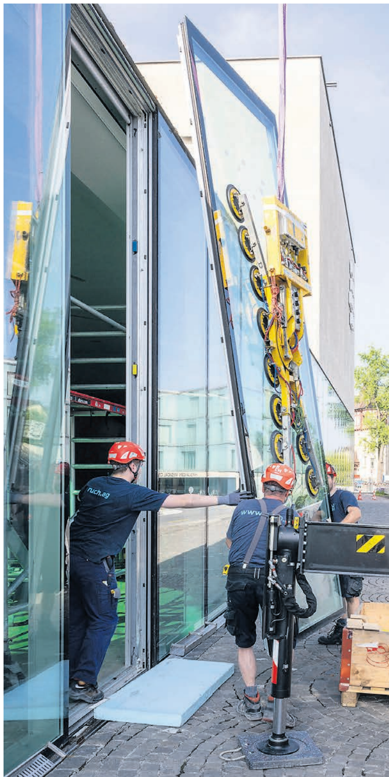
Austausch eines der Fenster an der Fassade.
