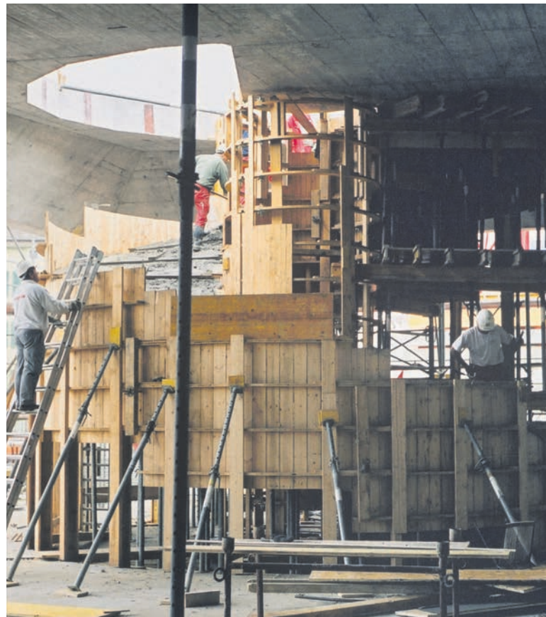
Schalung der neuen Wendeltreppe, Februar 2003. Bild: Herzog & de Meuron
